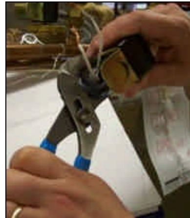
Loosening the conduit nut
