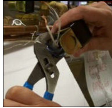
Loosening the conduit nut
